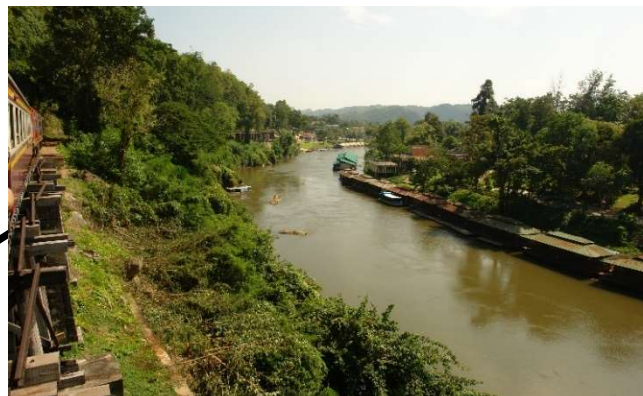
Das Tham-Krasae-Viadukt am Khwae Noi wird mit einer Geschwindigkeit von nur 10 km/h überquert
